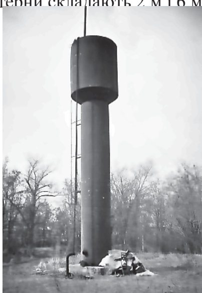
Рис. 3.2 Типовий вид наземного об'єкта «водонапірна вежа»
